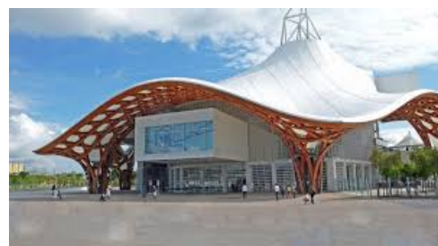
Shigeru Ban et Jean de Garstines, Centre Pompidou, Metz, 2010
